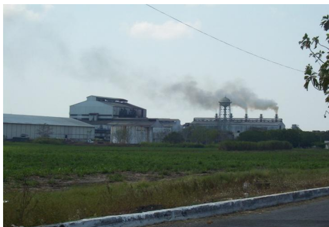
Ilustración 36 Instalaciones del Ingenio Huixtla
