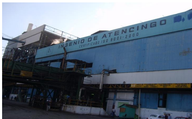
Ilustración 30 Instalaciones del Ingenio Atencingo
