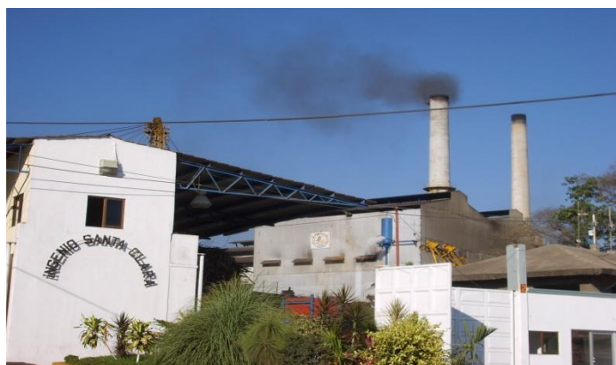
Ilustración 21 Instalaciones del Ingenio Santa Clara
